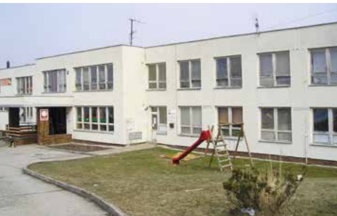
Sídlo ředitelství a prostory Azylového domu pro matky s dětmi (před rekonstrukcí)
